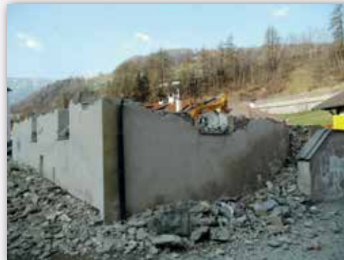
Das Mesnerhaus wurde abgerissen, der denkmalgeschützte Kellerbereich bleibt erhalten und wird teilweise von außen sichtbar konserviert.
